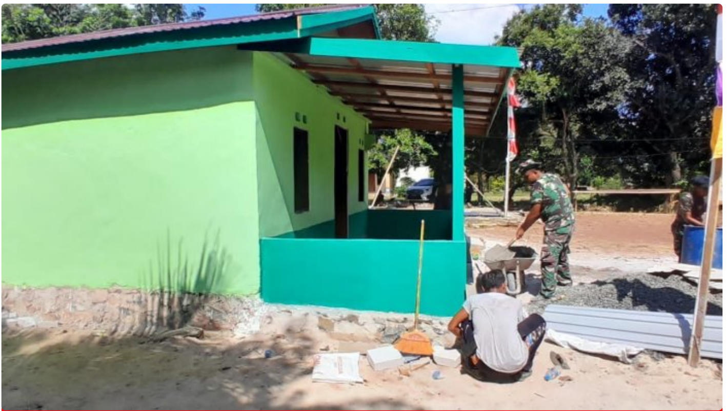
Pengerjaan Rumah Mbah Sandi Hampir Rampung
