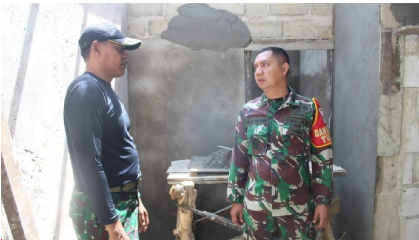
Dinding Rumah Mbah Yadi Mulai Di Plester Satgas TMMD
